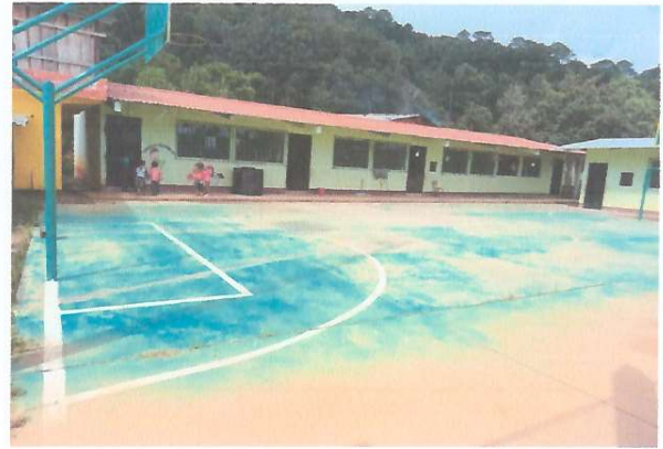
Foto 2: Cubierta de lámina
